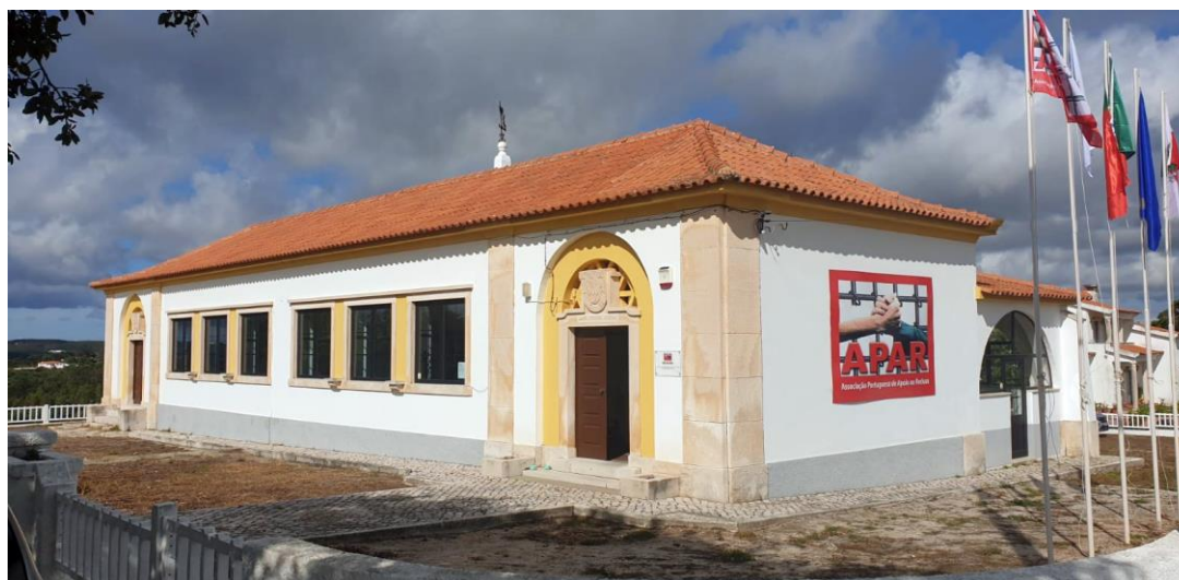
Edifício da Escola Primária – Rua da Escola Nova – Moita – 2500-368 Alvorinha
